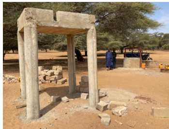
Gerüst für Hochbehälter
