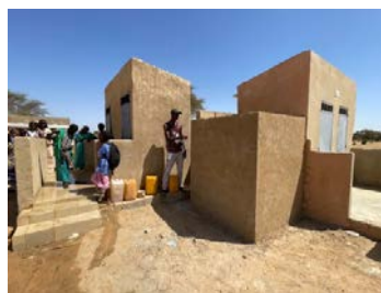
Neue Toiletten, rechts...
