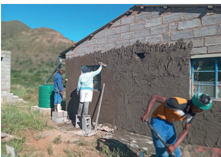
Lesotho - Anbringen von Außenputz
