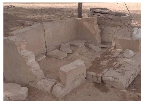
Schadhaft - Becken & Brunneneinfassung
